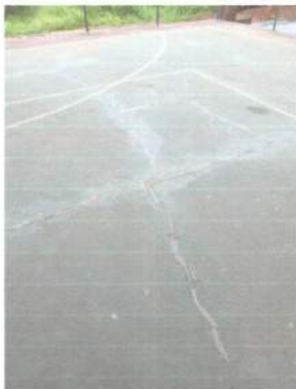
Correção de rachaduras no piso da quadra
