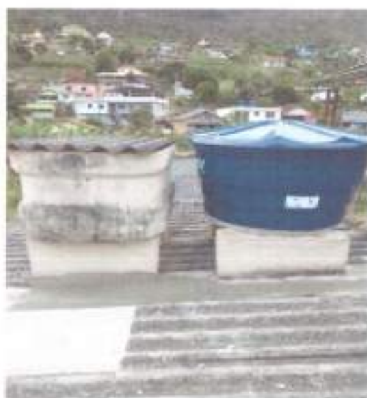
Retirada de rtreservatório de água e colocação de novo reservatório
