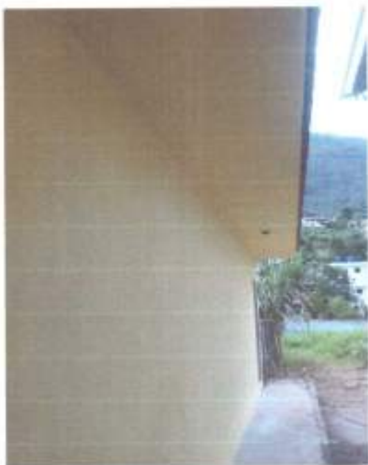
Aplicação de pintura com tinta acrílica na cor amarelo
