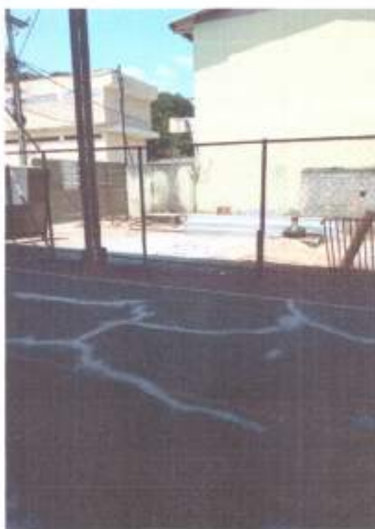
Correção de rachaduras no piso da quadra
