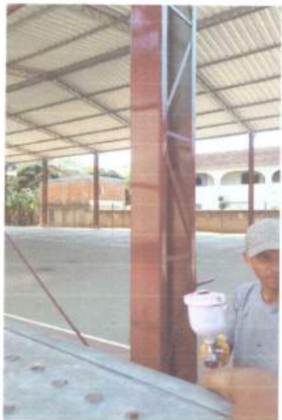
Pintura com tinta esmalte sintético
