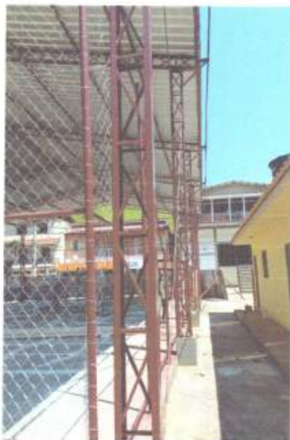
Pintura com tinta esmalte sintético
