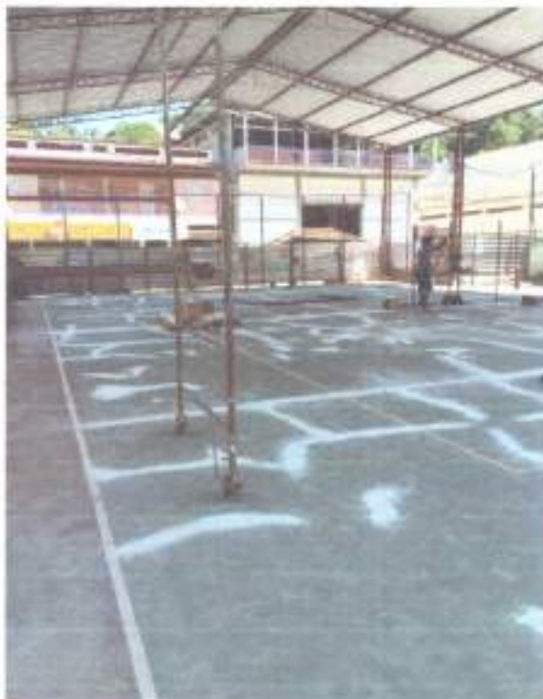
Colocação de tela no alambrado
