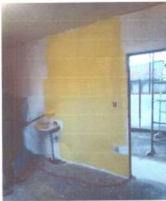
Aplicação de pintura com tinta acrílica na cor amarelo
