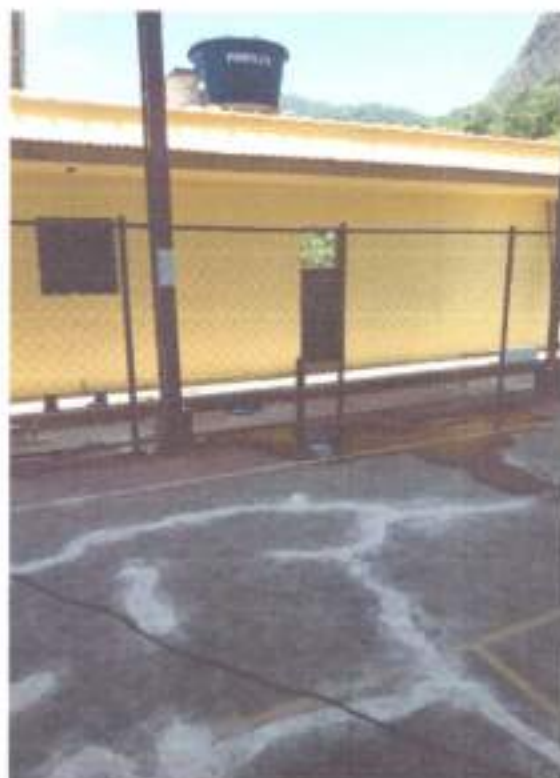
Correção de rachaduras no piso da quadra
